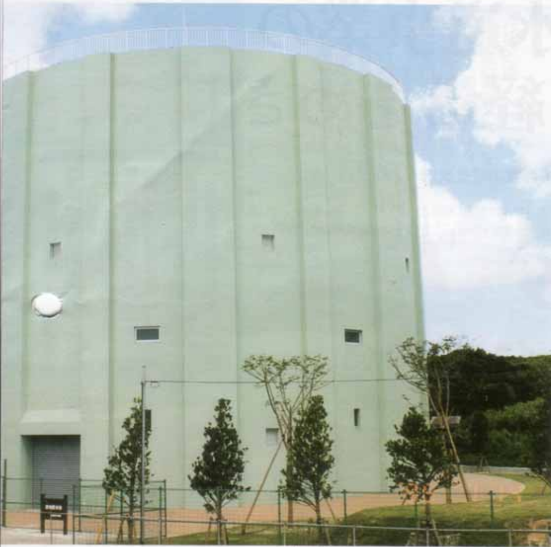
真地配水池（内径26.5m、水深6.0m、有効容量3,300m 3 ）
