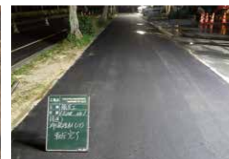
⑦舗装復旧(完了) 道路を元通りにして完成です。
