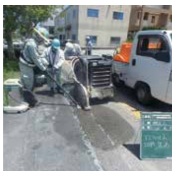
②アスファルト舗装切断 アスファルトカッターを使用します。
