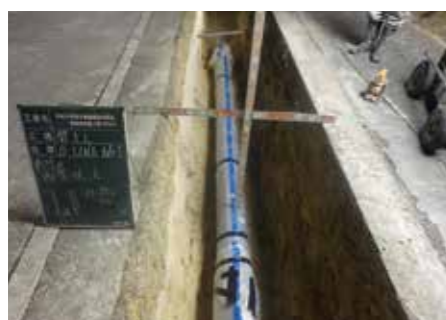
⑤新しい水道管布設 耐震性にも優れた新しい管を布設します。
