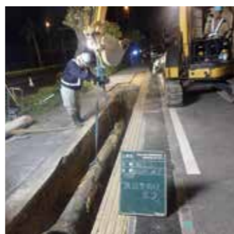
④既設管撤去 古い水道管を撤去します。
