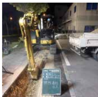
③工事のための掘削 掘削機械で穴を掘ります。
