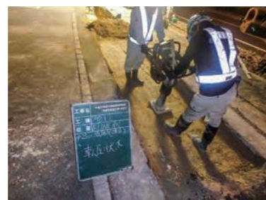
⑥ 埋戻し・締固め 道路に凸凹ができないように埋戻します。
