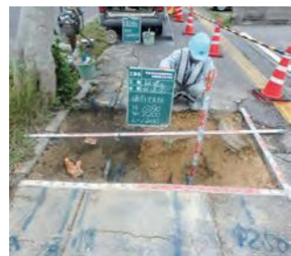
① 試掘 工事の前に他の占用物の調査をします。
