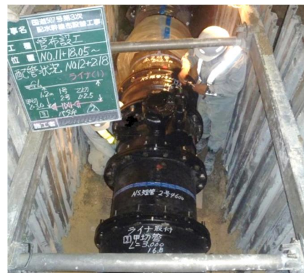
耐震管布設工事の様子
