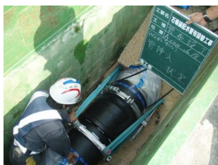
耐震管(NS形 φ450)の管接合の様子
