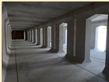
首里石嶺町雨水調整池(内部) 令和 6 年度（2024 年度）供用開始
