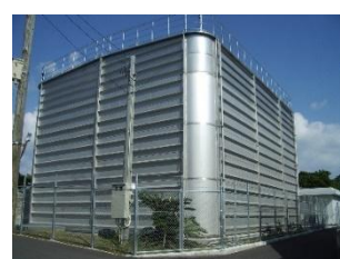
上識名配水池
