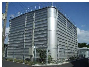
上識名配水池
