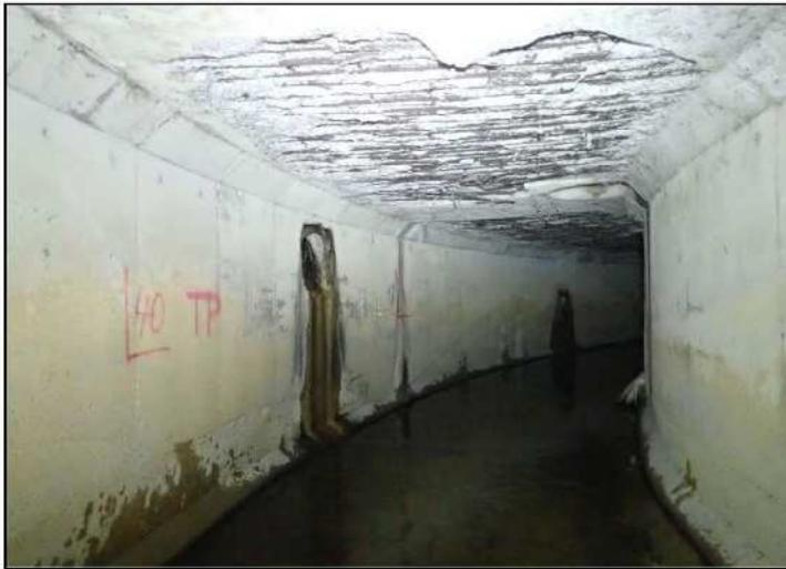
○ 暗渠内が腐食している状況が確認できます。このまま、腐食が進行すると道路陥没及び下水機能の停止が発生します。
