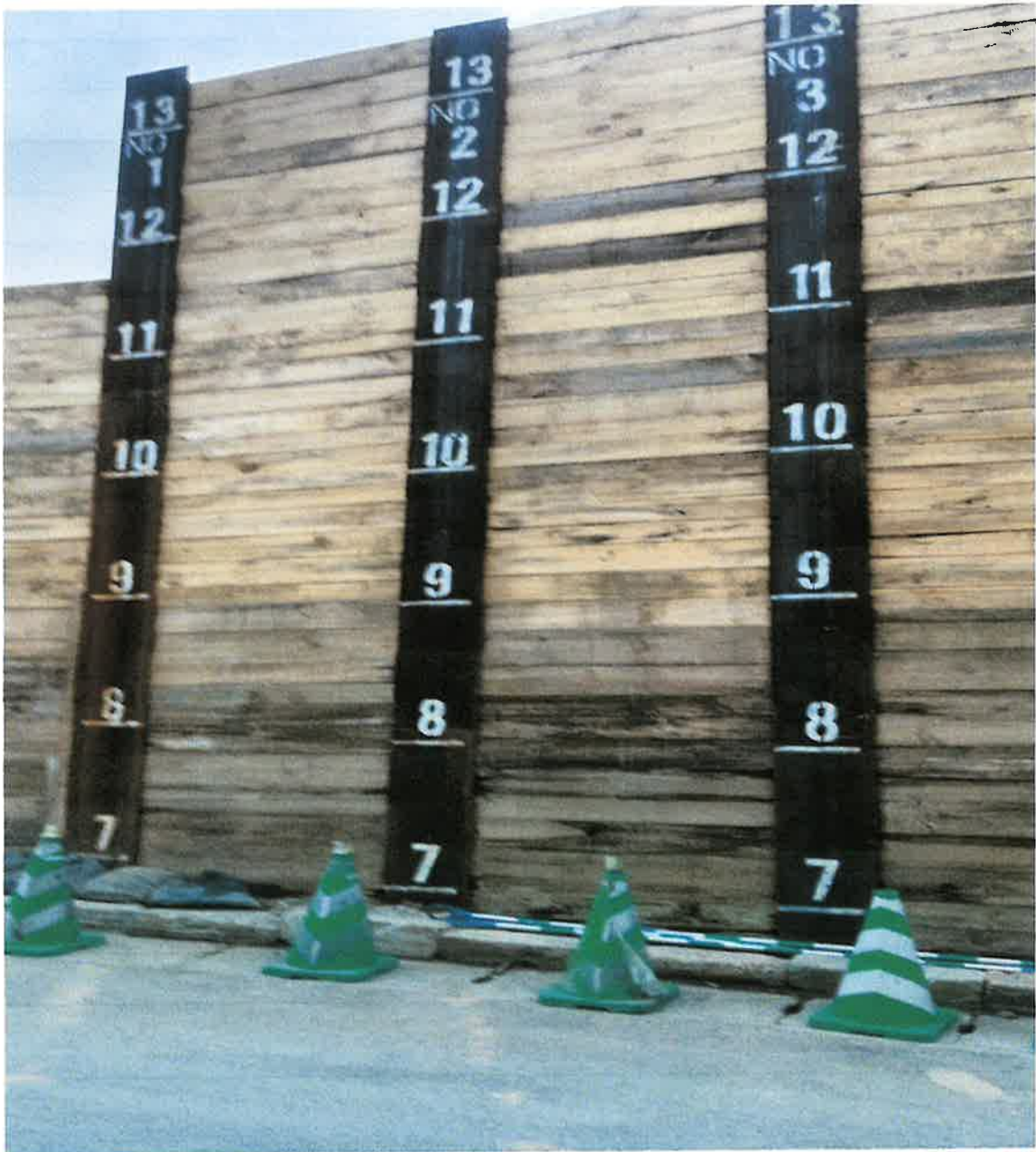
H鋼が地中に垂直に7メートル打ち込まれている。
