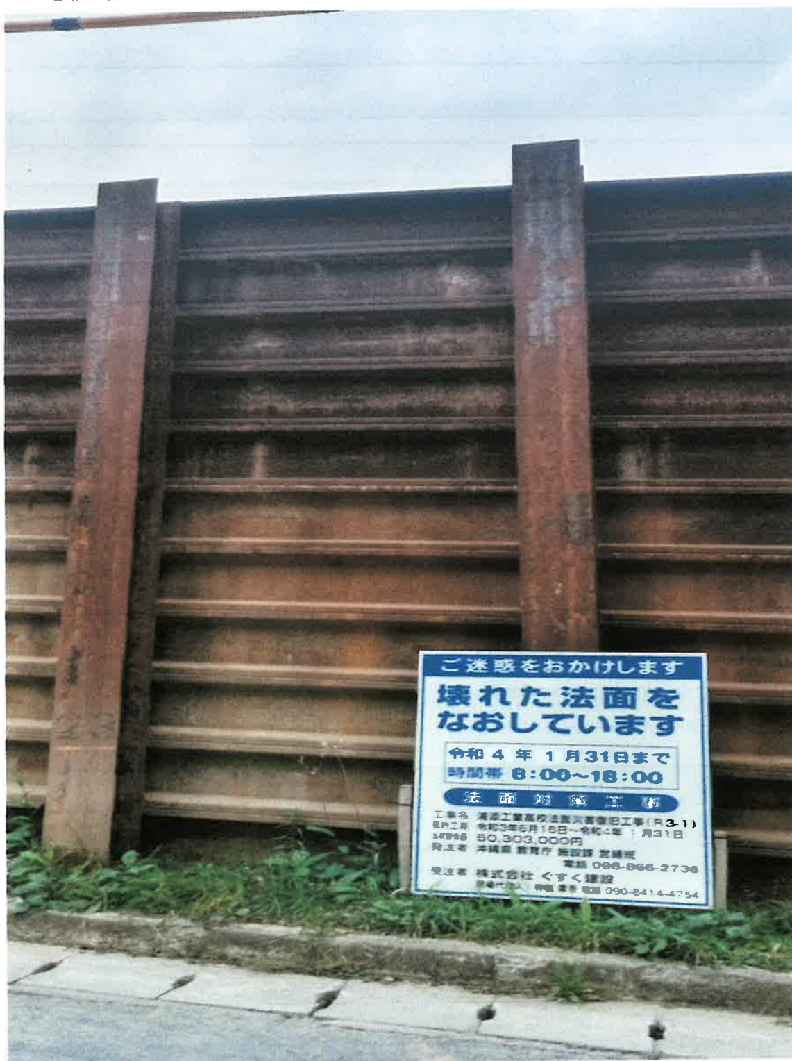
急傾斜崩落を防ぐため法面工事で使用されている「自立型擁壁」
