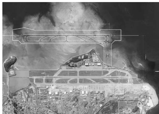
▲ 那覇空港第 2 滑走路 （提供：那覇港湾・空港整備事務所）
