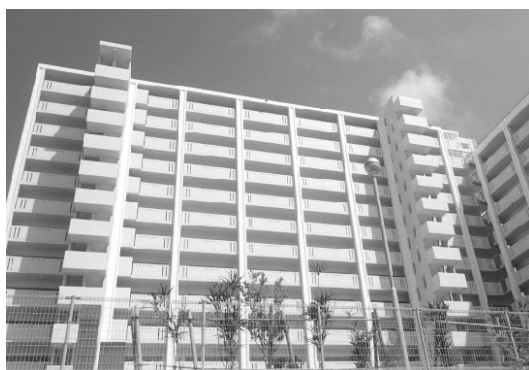
▲ 石嶺市営住宅（第5期建替え）
