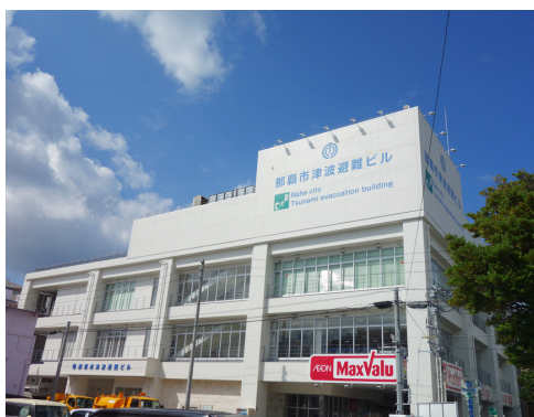
▲ 津波避難ビル
