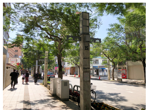
▲ 牧志中央線（無電柱化）
