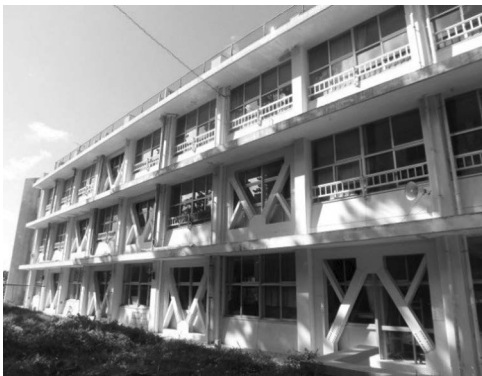
▲ 耐震改修後の松島小学校
