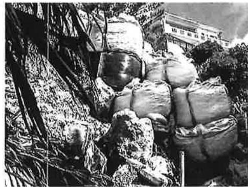
台風6号の影響で崩落した擁壁
