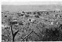
津波襲来後の南浜地区 (2011.4.24撮影 出典:東日本大震災アーカイブ宮城(石巻市) 著作権者:石巻市社会福祉協議会)
