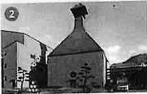
乾燥棟 (キルン塔)
