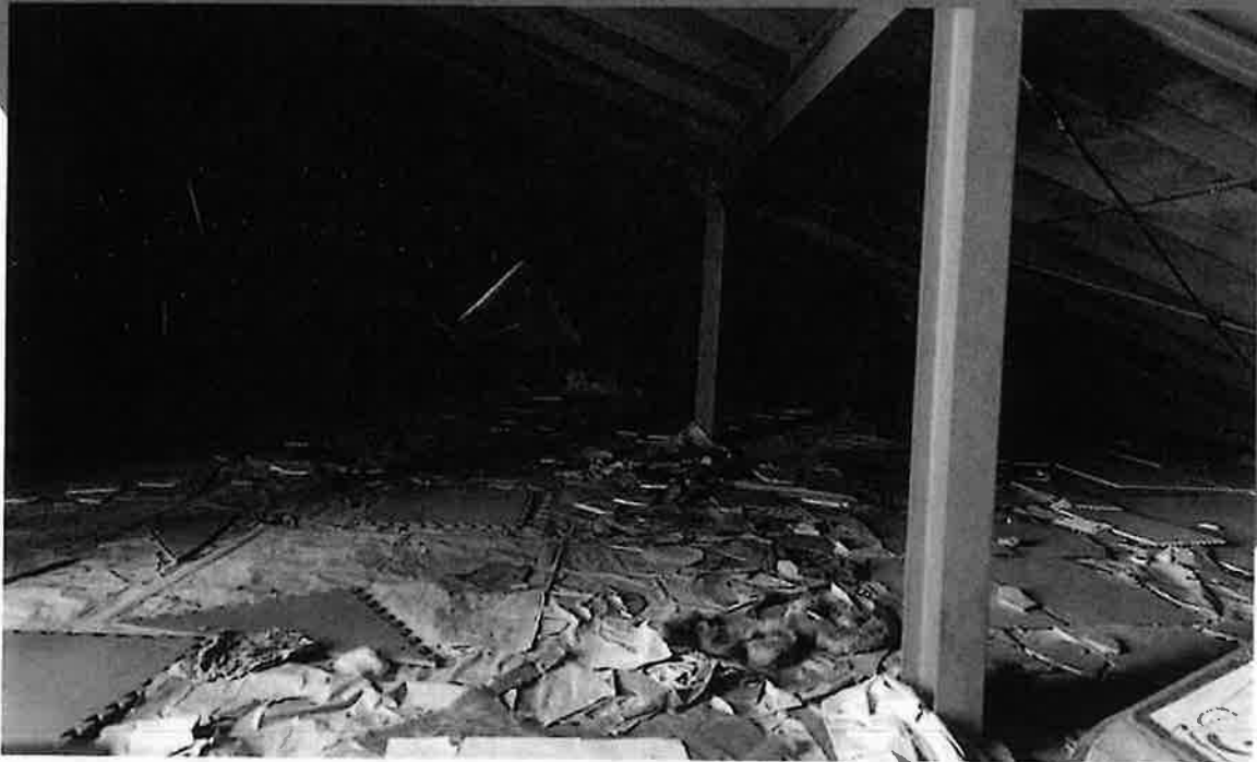
山元町震災遺構中浜小学校で子どもたちや地域住民が避難した屋根裏倉庫。翌朝まで90名がここで身を寄せ合っていた。
