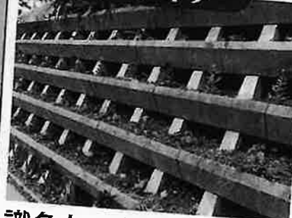
識名トンネル入り口、 花の植替え作業
