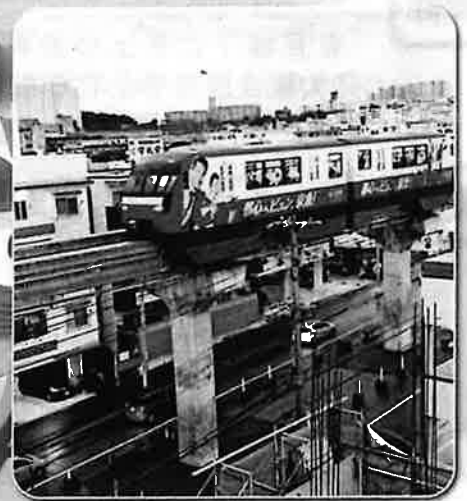
我が家の窓から見えるモノレールです。隣に建物建築中。見えなくなるのが・・・
