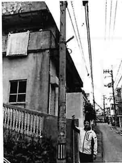
街灯・防犯灯の設置 (公園、通学路)
