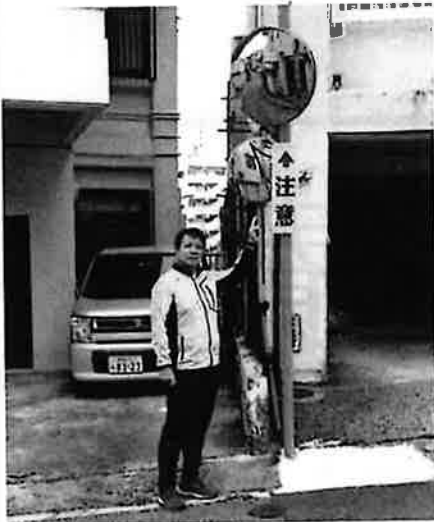
カーブミラーの設置
