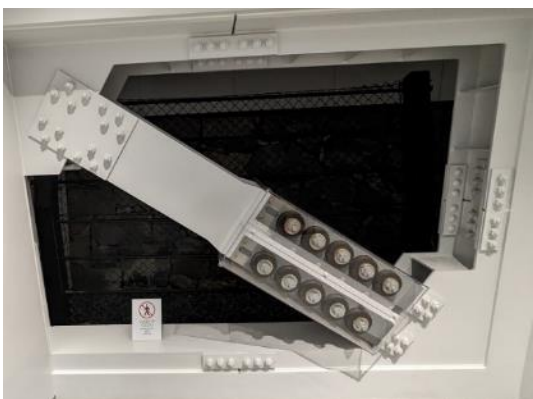
↑ ← 摩擦ダンパー 天守閣で採用した制振要素の一つである。大地震時にはプレート類が動くことで摩擦力が発生し、揺れのエネルギーを熱に変える。プレートは皿バネによって一定の力で締め付けられているため中小地震の揺れでは動かず、高い剛性で耐震性能を向上させる。
