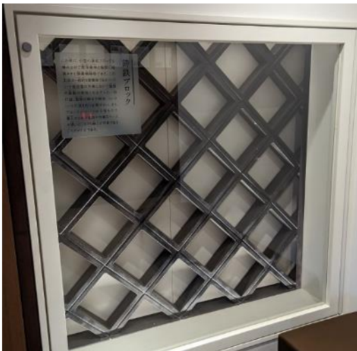
← 鋳鉄ブロック 小型の鋳鉄ブロックを積み上げて既存躯体と強固に接着させた耐震補強壁である。この工法は一般的な耐震壁であるコンクリート壁設置の作業において騒音や振動の原因となるアンカーの打設、型枠の組立や解体、コンクリート打設を行う必要がない。また、ブロック一つ一つが小型なので、搬入のための通路や作業スペースが狭いところでも施工が可能であることがメリットである。
