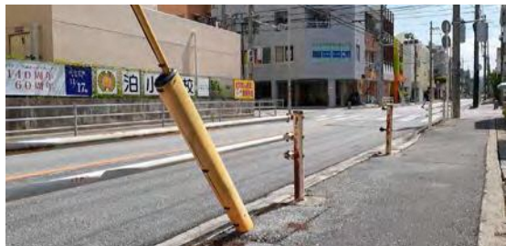
市道泊中央線の横断防止柵
