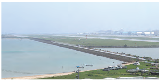
那覇空港南側船揚場の整備予定地
