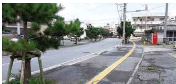
公共下水道工事箇所(現在の市道烏堀12号)
