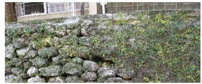
安謝小通学路の野面積み石垣部分にある空洞
