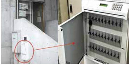
鍵管理システムの実証実験が始まる
