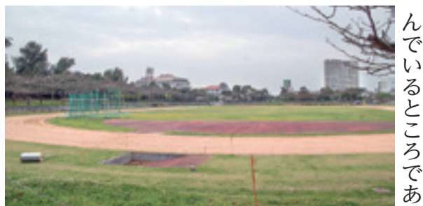
奥武山陸上競技場の現況
