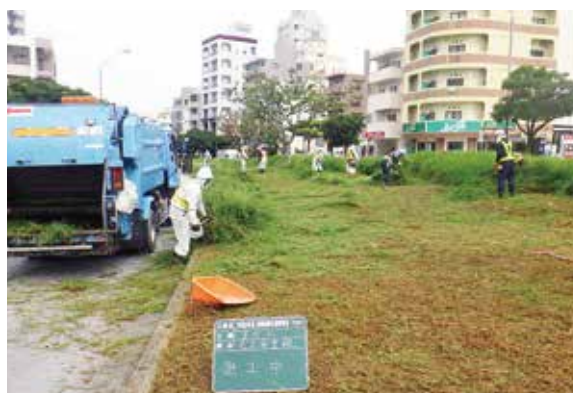
除草作業の状況(天久安里線中央分離帯)
