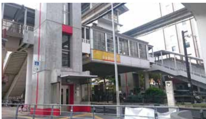
故障から復旧したモノレール駅の昇降機
