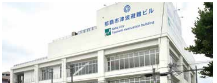
平常時は地域交流の場として活用される津波避難ビル
