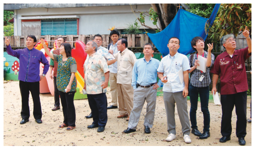
建物の外側から老朽箇所を確認
