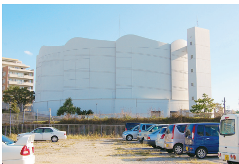
◀泊配水池(上之屋の市役所仮庁舎近く)
