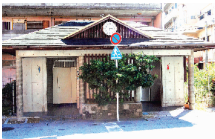
東町市営住宅前の公衆トイレ
