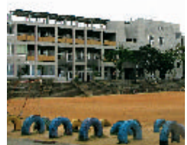
改築された城南小学校校舎(平成20年1月完成)
