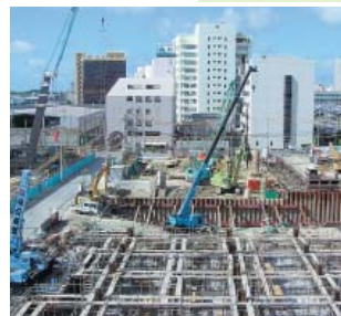
旭橋再開発事業の建設現場
