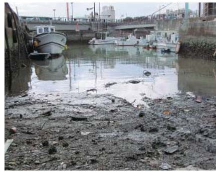
土砂が堆積した壺川漁港代替船揚場
