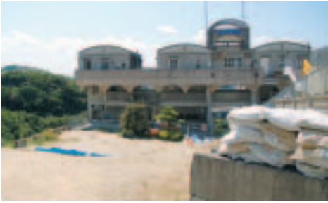
首里鳥堀町 5 丁目の被災現場
