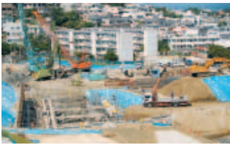
久場川市営住宅建替工事
