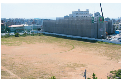
売却が検討されている新庁舎候補地
