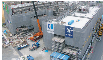
本市発注の公共工事（上下水道局庁舎）
