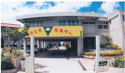
クーラー整備予定の松島中学校
