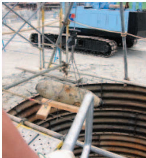
ライナープレートを使用している不発弾処理
