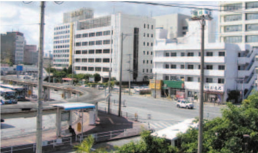
旭橋再開発事業地区
