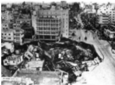
琉海ビル陥没事故 前島 11月26日
