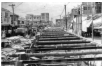
ガーブ川の改修工事 ガーブ川にふたをする 1962年
