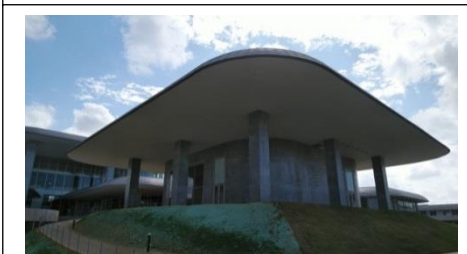
宮古島市未来創造センター 令和元年8月完成
