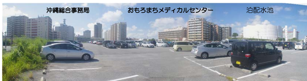
図表 36：仮庁舎跡地の現状
