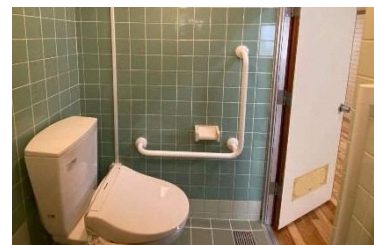
▼ バリアフリー化改修工事を実施したトイレ
