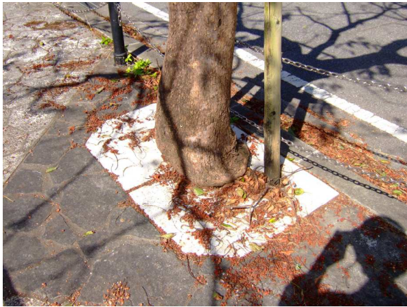
□植樹樹と被覆ブロックで根元を処理
