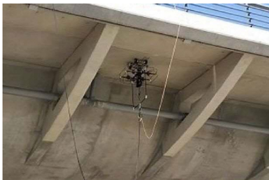
写真-1 ドローンを活用した点検ロボット
