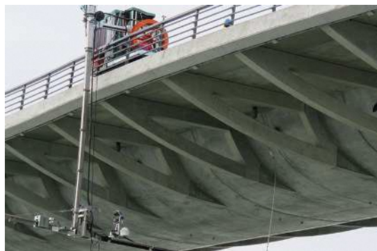
写真-2 橋梁点検支援ロボット
