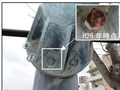
写真-1-3 横張取付け部のボルトナットの更新(No16)
