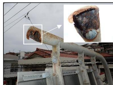
写真-1-7 支柱本体の著しい腐食(No08)
