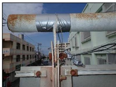
写真-1-6 標識取付部ゆるみ、腐食(No12)
