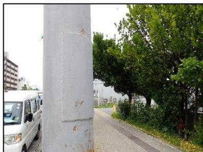
写真-1-4 支柱本体の当て板補修(No23)
