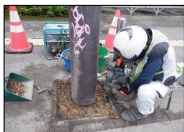
掘削点検状況（舗装撤去）
