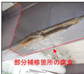
写真-1.3 おもろまち駅 A 橋(連絡通路) 屋根梁部の部分補修後にみられる再劣化(腐食)
