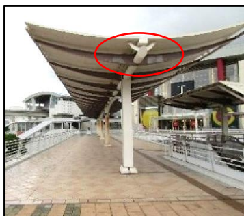
写真-1.3 おもろまち駅 A 橋(連絡通路) 屋根梁部の部分補修後にみられる再劣化(腐食)
