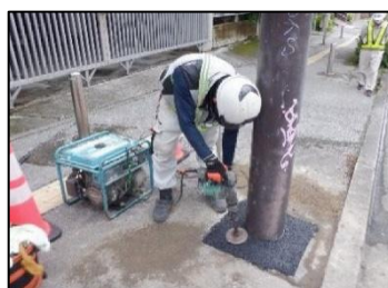
掘削点検状況（復旧材転圧）
