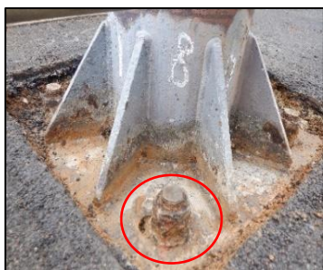
写真-1.1 Ⅲ判定 門型標識① アンカーボルト・ナットの腐食
