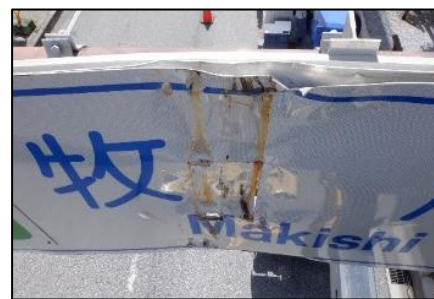
写真-1.2 Ⅲ判定 門型標識① 標識板の変形欠損(衝突痕)
