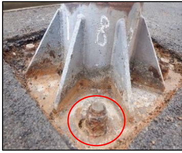
写真-1.1 Ⅲ判定 門型標識① アンカーボルト・ナットの腐食
