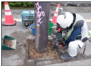
掘削点検状況（舗装撤去）
