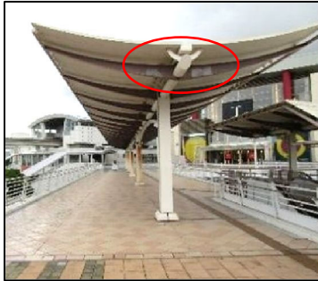
写真-1.3 おもろまち駅 A 橋(連絡通路) 屋根梁部の部分補修後にみられる再劣化(腐食)
