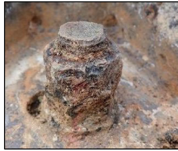
写真-1.1 Ⅲ判定 門型標識① アンカーボルト・ナットの腐食
