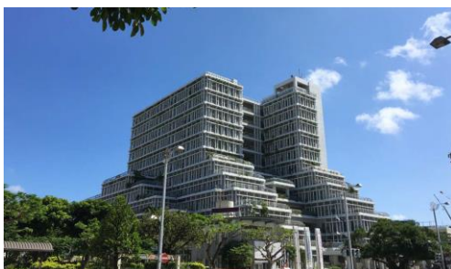
壁面を緑化した那覇市役所 (出典：都市計画マスタープラン)
