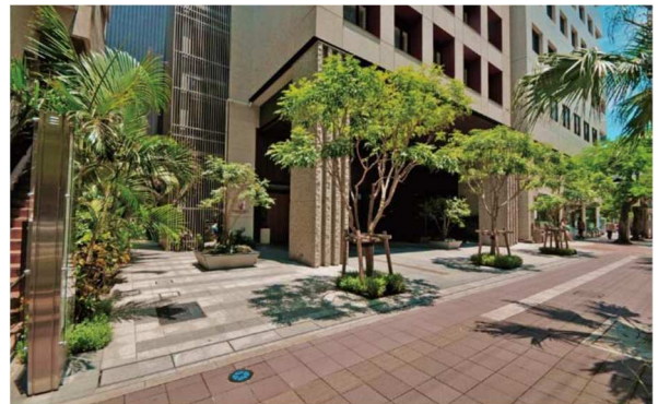
アルモントホテルの公開空地
