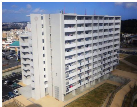
▲ 建替え後の宇米原市営住宅（第4期）
