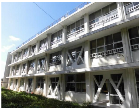
▲ 耐震改修後の松島小学校
