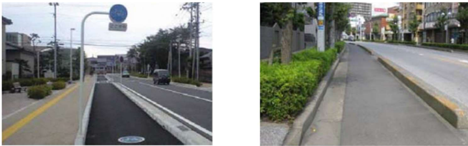
図 4-6 自転車道の構造的分離 縁石で分離した例（左）縁石と植栽帯で分離した例（右）
