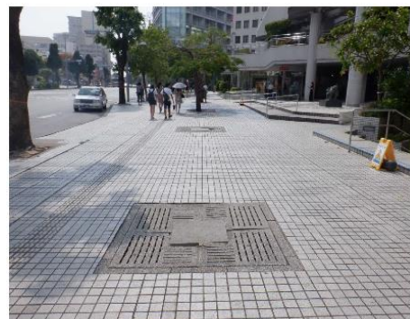
事業① 修繕箇所
