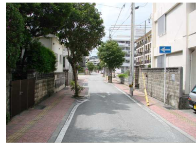
道路空間の再配分により一方通行化されたコミュニティ道路 (市道小椋 20 号線)
