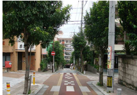
生活道路におけるコミュニティ道路 (市道泉崎楚辺西線)
